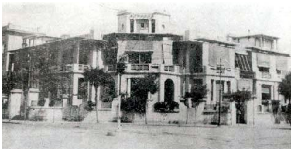
华北水利委员会外景（旧址仍存且已获修复，位于天津市自由道民生路交口西北角）
